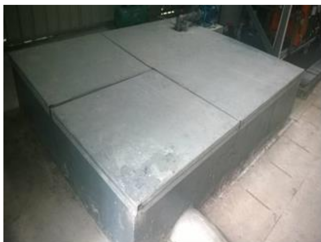
污水处理站事故应急池（4m 3 ）
