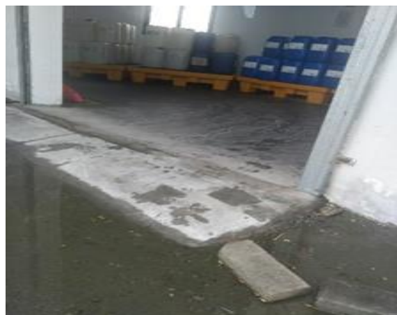
化学品仓库地面防渗漏措施
