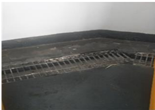
化学品贮存区导流沟
